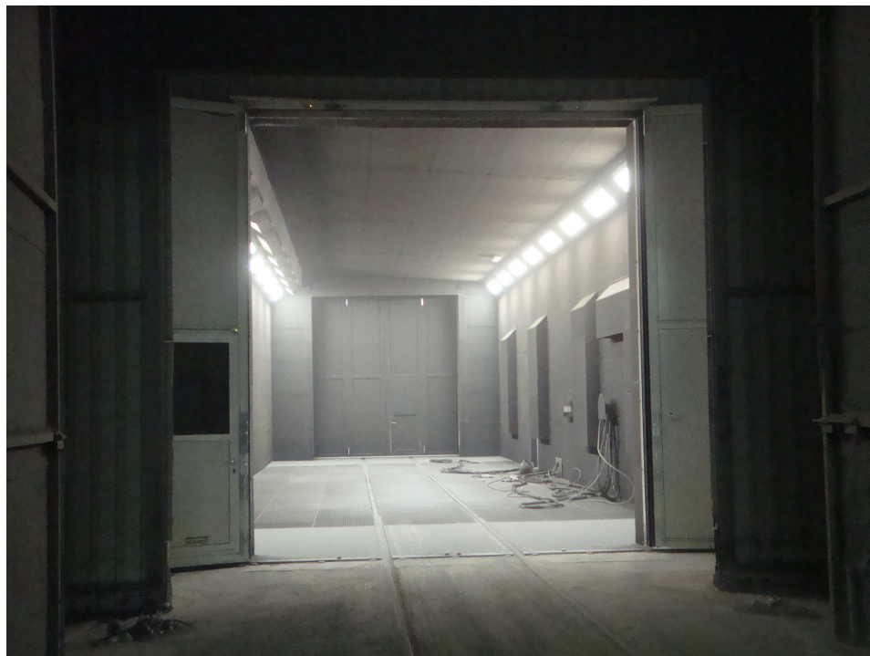
Blick von der Strahlhalle Einwegstrahlmittel in die Halle Mehrwegstrahlmittel
