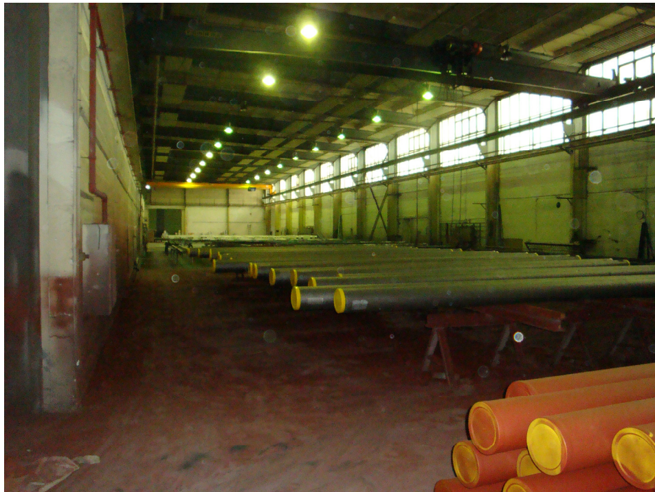
Beschichtungshalle Korrosionsschutz Naumann
